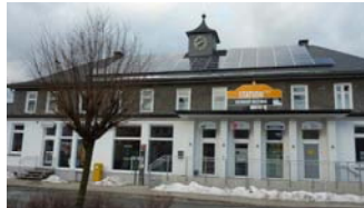
... und nach der Sanierung.
